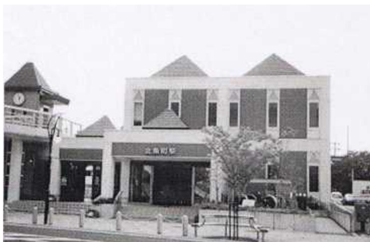
図 2-2-10 再開発事業で新築された北条町駅
