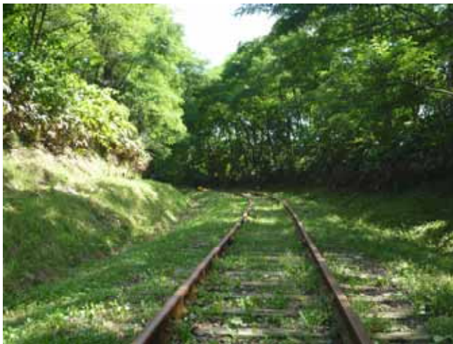
図 1-2-3 幌内線廃線跡
